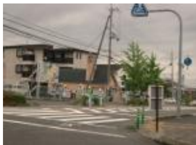
ジェイオー建設 (全県下一斉奉仕作業 5月30日)
