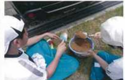
芝生目土入れ作業
