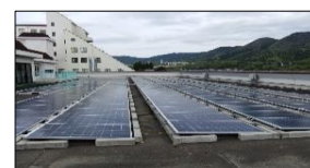
【県立ひょうごこころの医療センター:コンクリートブロック据置型】
